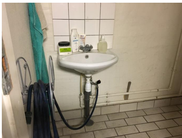
Fælles toilet i kælder.
