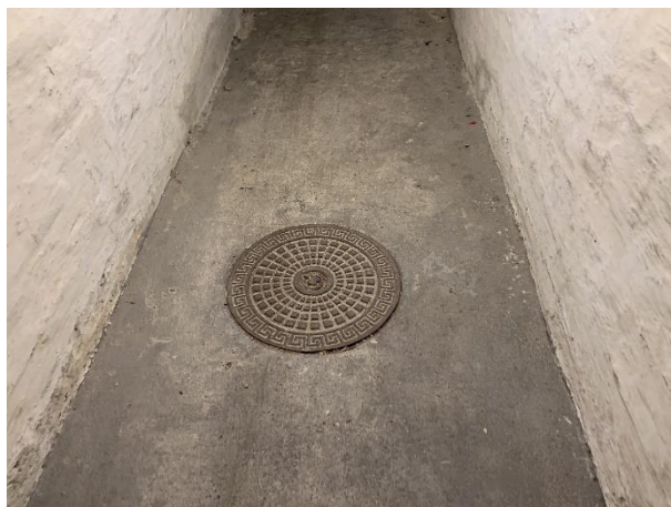
Kloakdæksel i kælder
