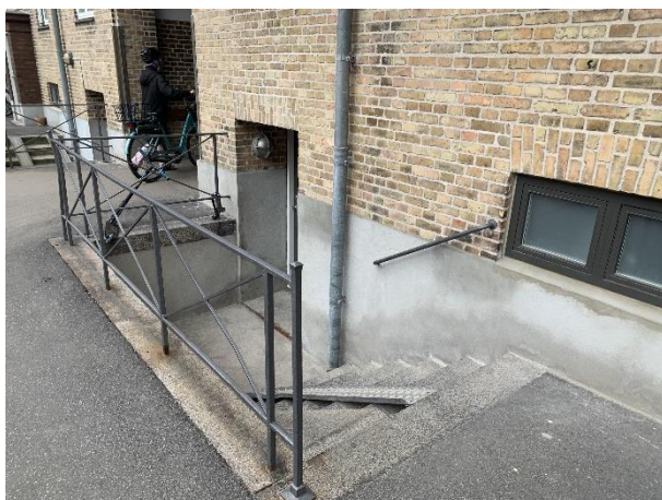
Nedgang til kælder.
