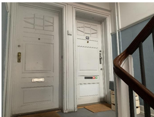
Opgangsdøre på hovedtrapper.
