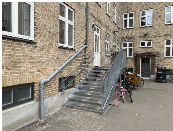
Ståltrappe til institution.
