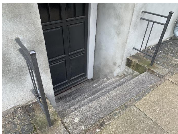
Kælderdør mod gade.
