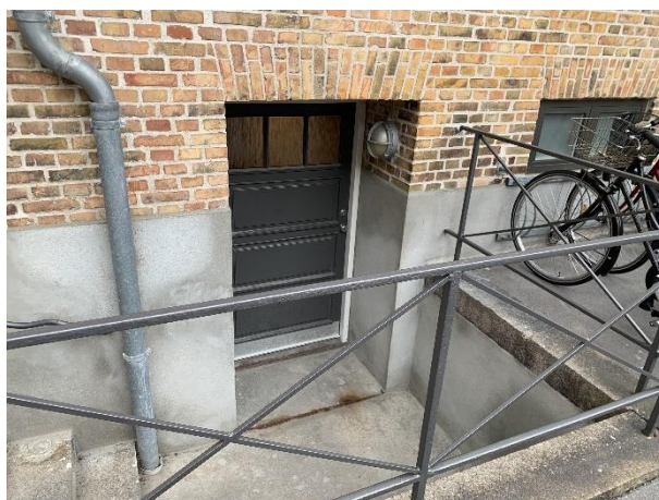
Kælderdør mod gården.
